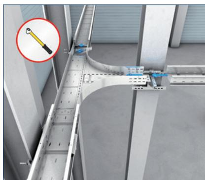
Установите T-образный отвод (WPRA) с соединительной пластиной (VB) в лотке и закрепите в двух местах с каждой стороны несущих профилей.
